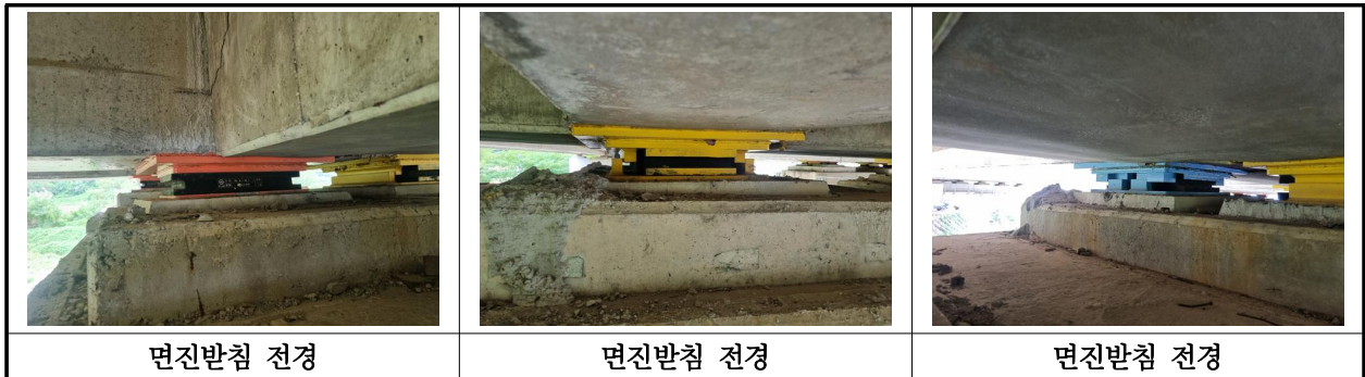
【사진 21.3.40】 교량받침 전경
