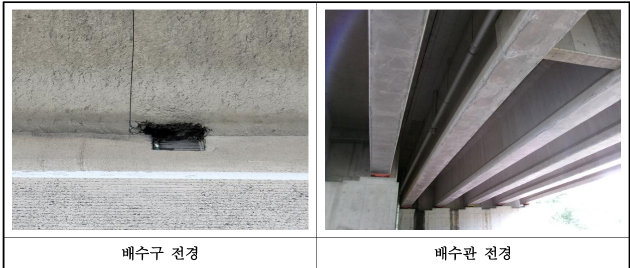
【사진 21.3.49】 배수시설 전경
