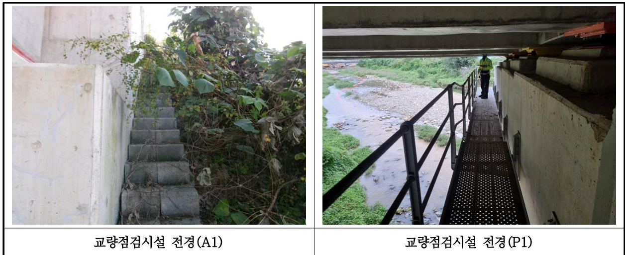
【사진 21.3.26】 교량 점검시설 전경
