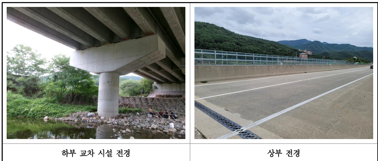
【사진 21.2.1】 부재 현장측정 전경
