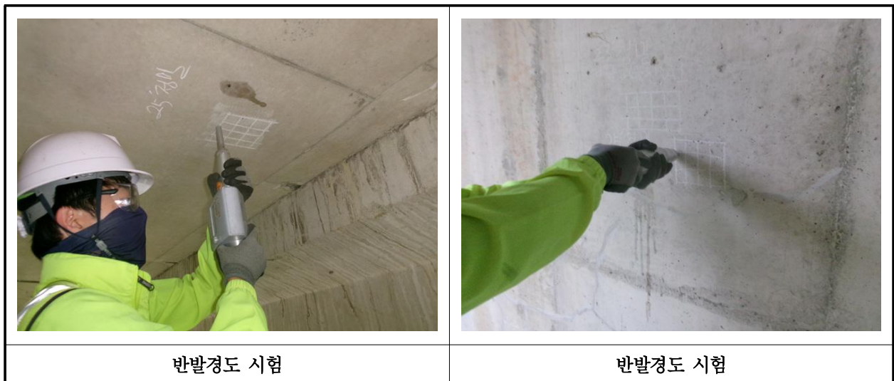
【사진 21.4.2】반발경도시험 현장사진
