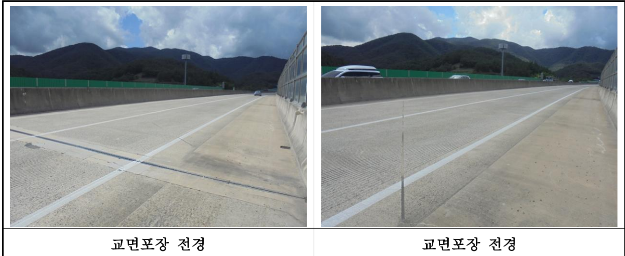
【사진 21.3.20】 교면포장 전경
