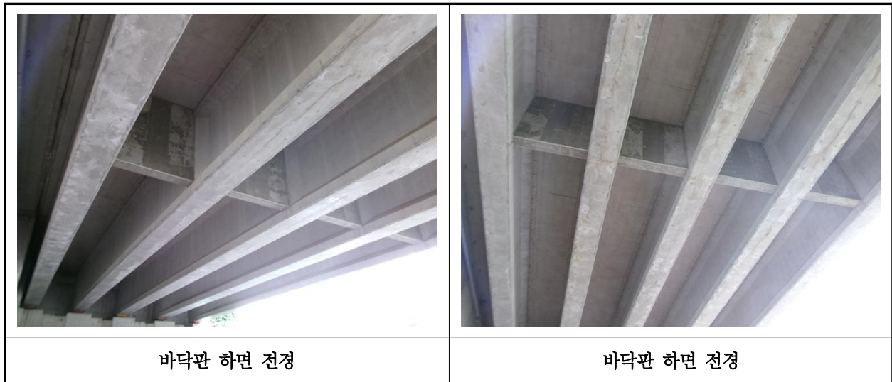
【사진 21.3.2】 바닥판하면 전경
