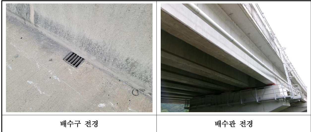
【사진 21.3.22】 배수시설 전경
