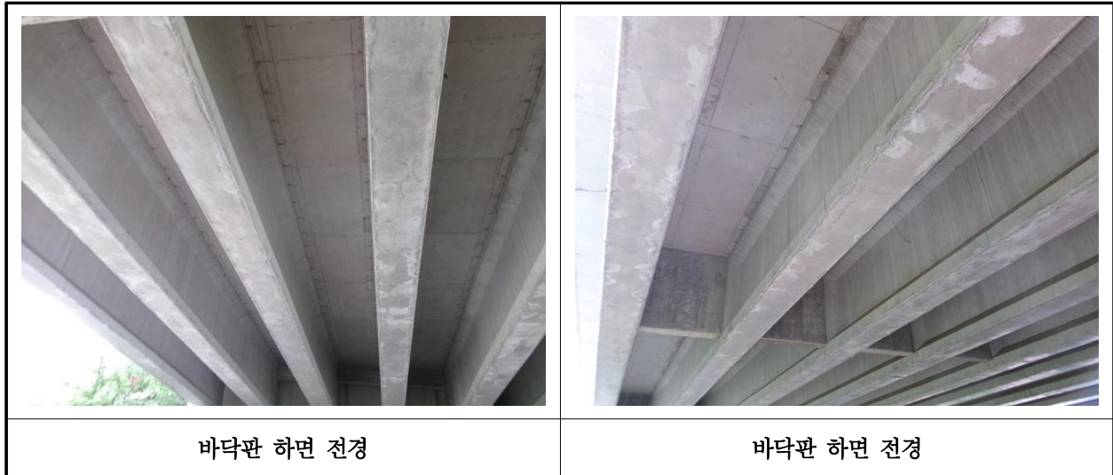
【사진 21.3.29】 바닥판하면 전경
