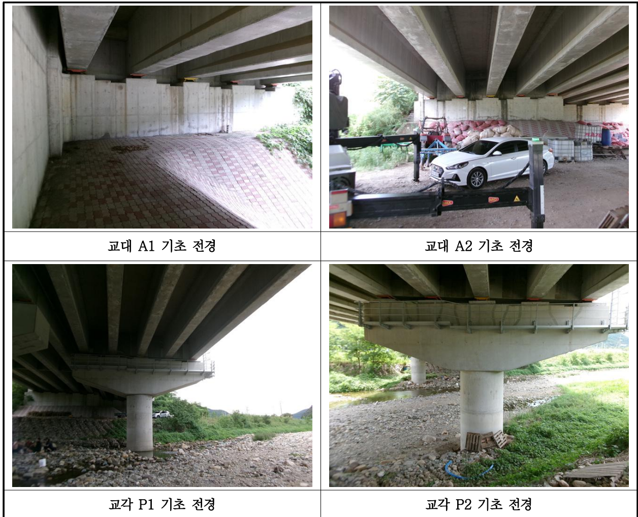
【사진 21.3.39】 기초 전경
