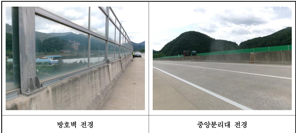
【사진 21.3.24】 방호벽 및 중앙분리대 전경
