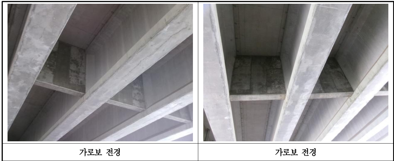
【사진 21.3.6】 가로보 전경
