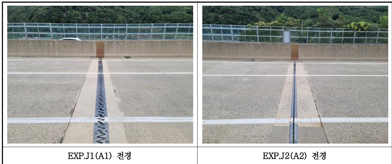
【사진 21.3.44】 신축이음장치 전경
