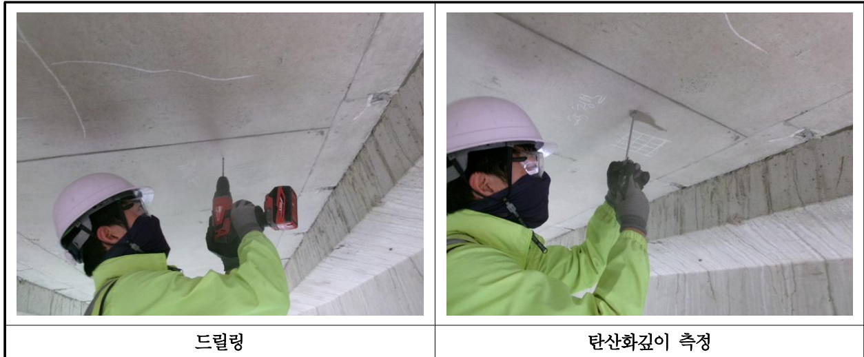
【사진 21.4.3】 탄산화 깊이 측정 현장사진
