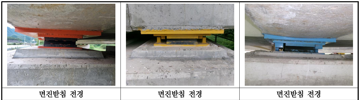
【사진 21.3.13】 교량받침 전경
