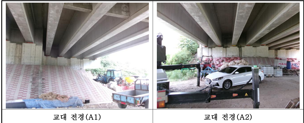
【사진 21.3.8】 교대 전경
