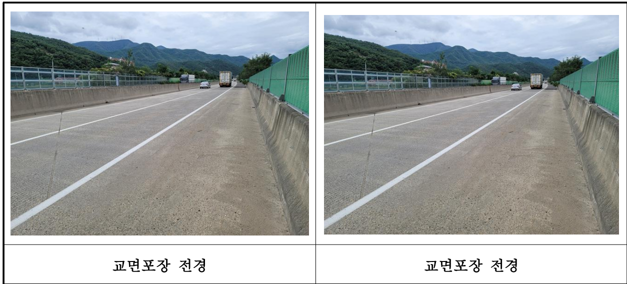
【사진 21.3.47】 교면포장 전경
