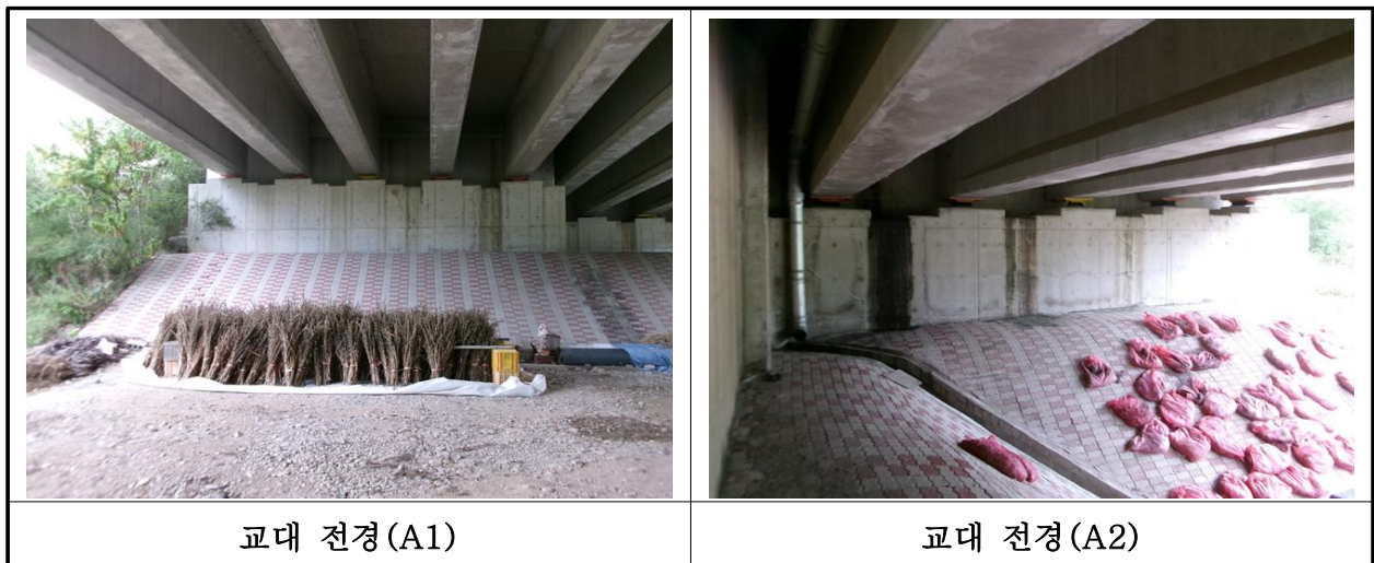
【사진 21.3.35】 교대 전경
